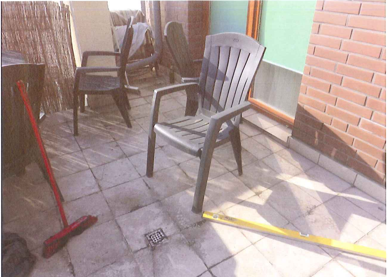
Widok tarasu oraz instalacji odwodnienia powierzchni balkonu-tarasu –wyższej kondygnacji – widoczne znaczne wysolenia ( bały nalot grubą warstwą) świadczą o stałych przeciekach wody poza koszem i rurą spustową
