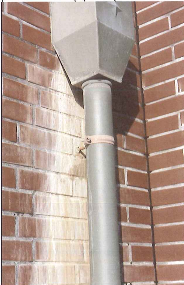
Widok tarasu oraz instalacji odwodnienia powierzchni balkonu-tarasu –wyższej kondygnacji – widoczne znaczne wysolenia ( bały nalot grubą warstwą) świadczą o stałych przeciekach wody poza koszem i rurą spustową
